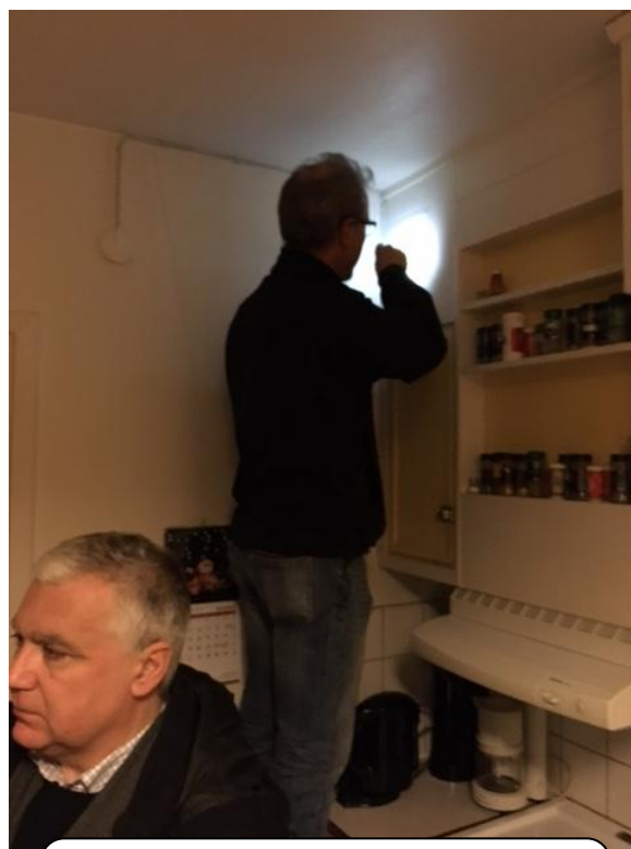
Personal från Hemkomfort undersöker hur ventilationslösningen kan göras hos Peter Bloch. I förgrunden syns Peter Nylander från styrelsen.
