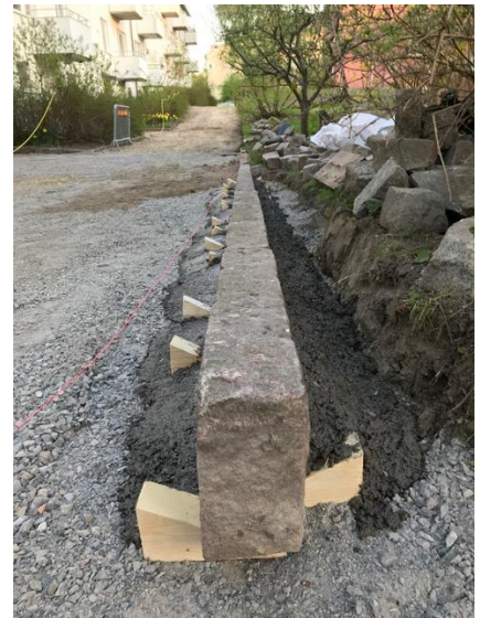
Rännan vid Sicklingsvägen 12, asfalten borta vid Bordsvägen 39 – 47 samt fastgjutning av kantsten
