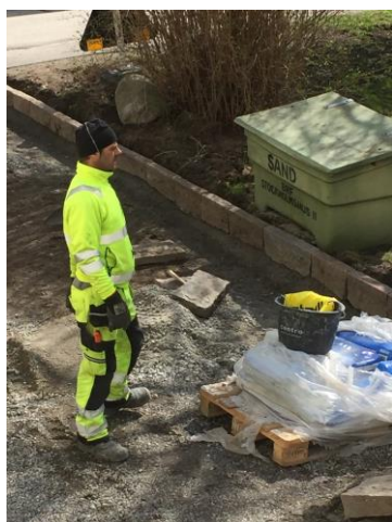
Kantstenen sätts i ordning och gjuts fast med betong vid garagens infart vid Bordsvägen 66 - 68
