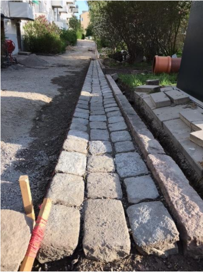
Rännan vid Sicklingsvägen 12, asfalten borta vid Bordsvägen 39 – 47 samt fastgjutning av kantsten
