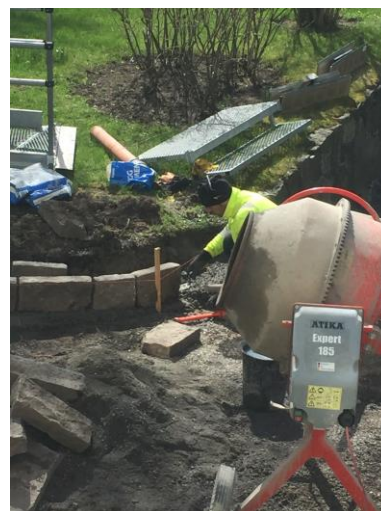
Kantstenen sätts i ordning och gjuts fast med betong vid garagens infart vid Bordsvägen 66 - 68
