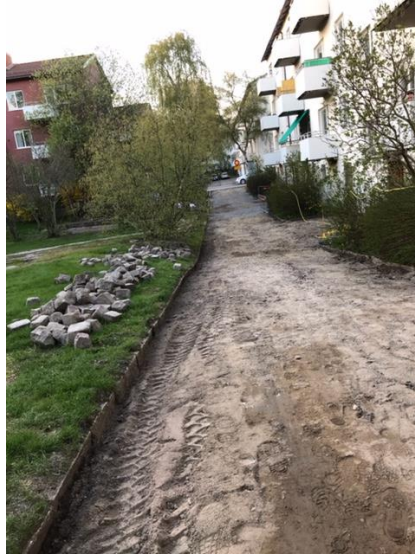
Rännan vid Sicklingsvägen 12, asfalten borta vid Bordsvägen 39 – 47 samt fastgjutning av kantsten
